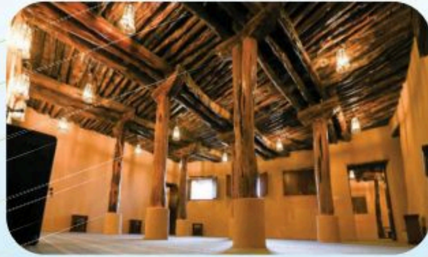
مسجد تاريخي بعد ترميمه
