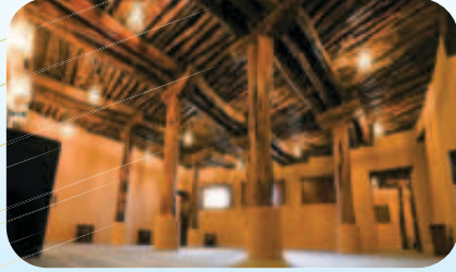
مسجد تاريخي بعد ترميمه
