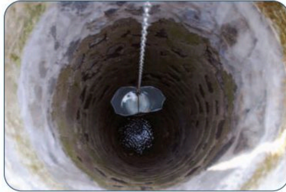
شكل 3-8 آبار المياه الجوفية
