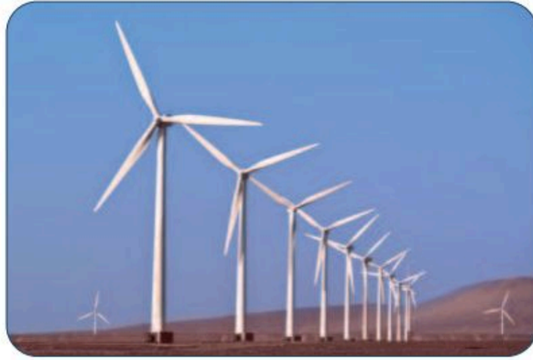
شكل 7-19 توليد الكهرباء باستخدام طاقة الرياح
