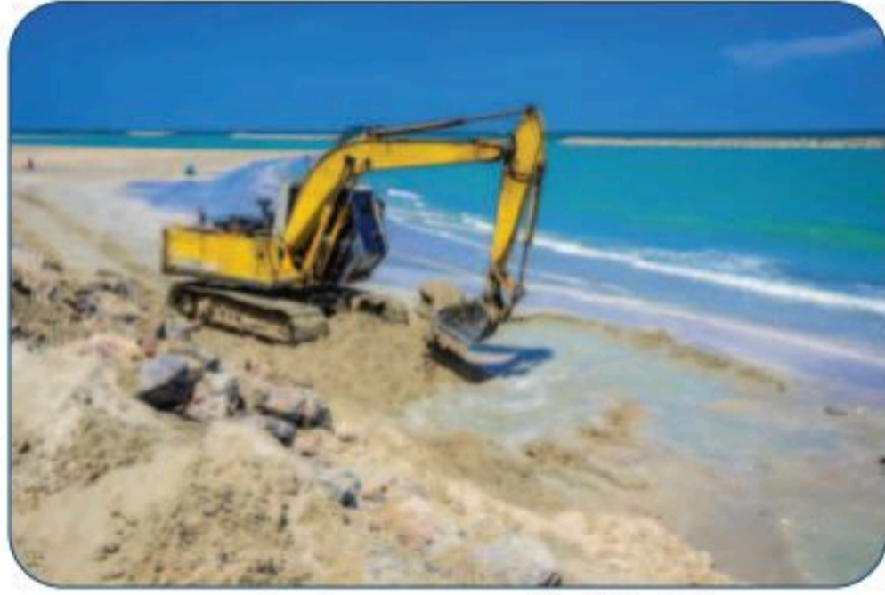
شكل 8-24 تجريف مياه البحر.
