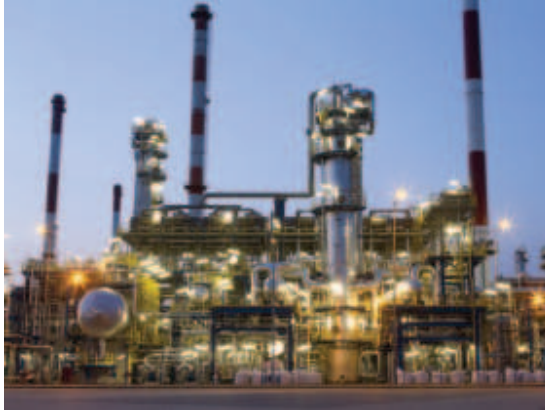
محطة توليد الكهرباء في الجبيل
