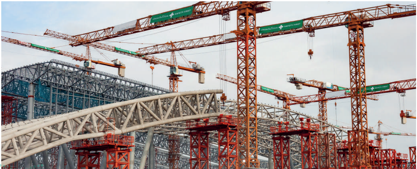
شكل 1.8: إنشاء قطار الأنفاق (المترو) في الرياض
