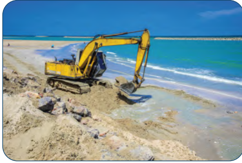
شكل 8-24 تجريف مياه البحر.
