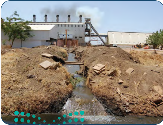
شكل 20-8 مخلفات الصرف الصناعي
