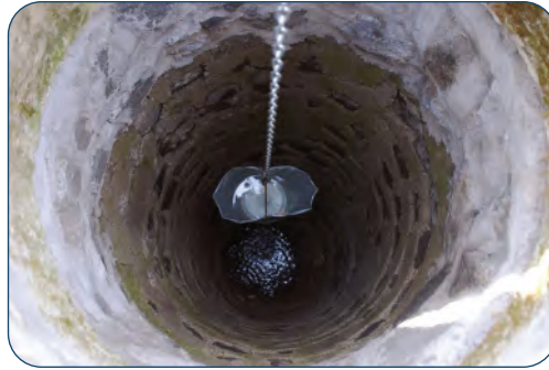
شكل 3-8 آبار المياه الجوفية
