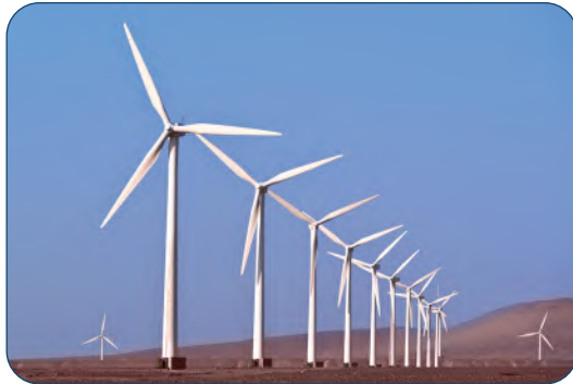
شكل 7-19 توليد الكهرباء باستخدام طاقة الرياح
